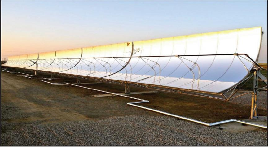
صورة لتقنية تحلية المياه بالطاقة الشمسية Water FX التي تستخدم أشعة الشمس لإنتاج الحرارة لتنقية المياه سواء المالحة أو الملوثة
